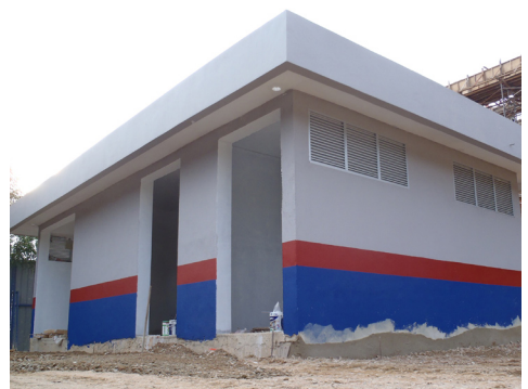
Substation Utama (SSU)
